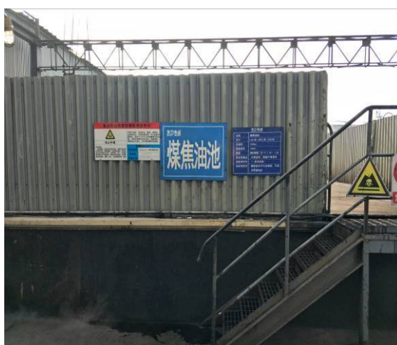
三期煤焦油收集池
