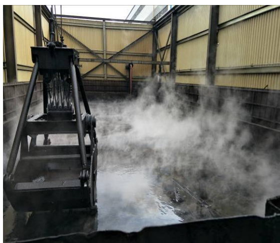
一期二期酚水收集池
