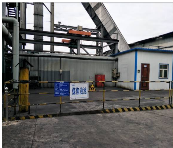
一期二期煤焦油收集池
